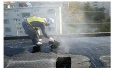
下地調整及び仮防水処理
