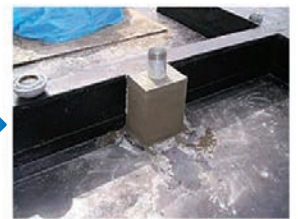
防水工事に適した形状への加工
