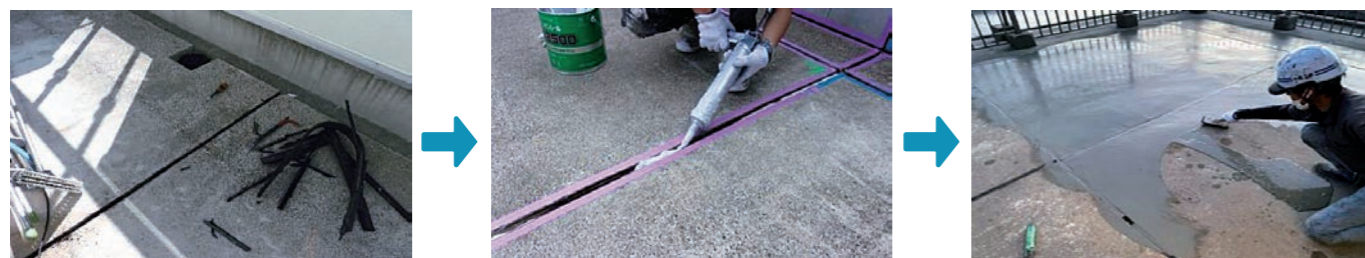
■ 既存伸縮目地材及びドレン回りの撤去 (ハツリ機、ケレン棒等を用いる)
