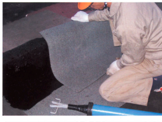
2.ダービーサンドを施工する
