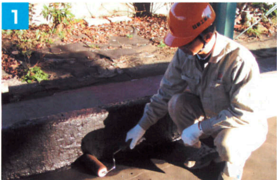
1 立上り部にプライマー-AQを塗布する。(既存層撤去時)
