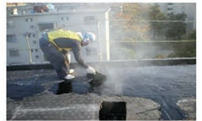
下地調整及び仮防水処理
