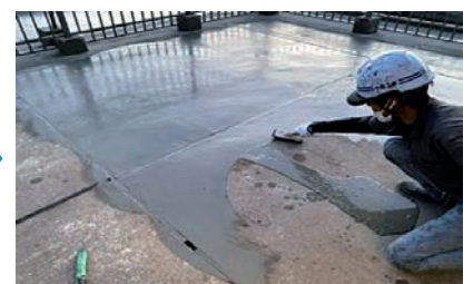
■ 下地調整及び仮防水処理
