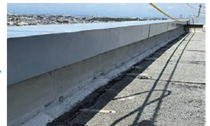
■ 下地調整及び仮防水処理
