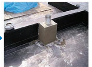
防水工事に適した形状への加工
