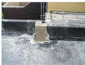
欠損部のモルタル補修
