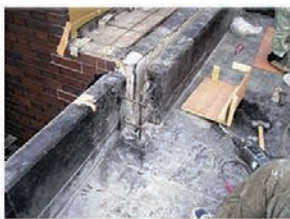
欠損部のモルタル補修
