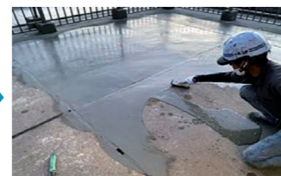
■ 下地調整及び仮防水処理
