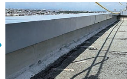
■ 下地調整及び仮防水処理
