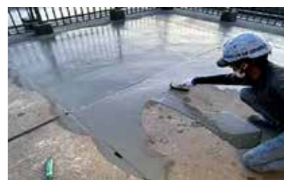
■ 下地調整及び仮防水処理
