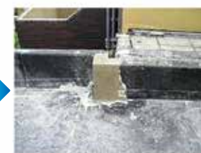
欠損部のモルタル補修
