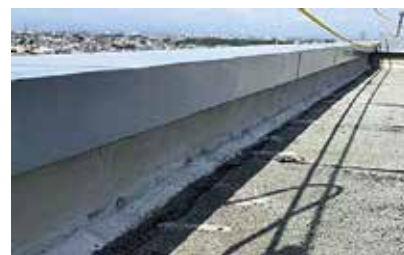
■ 下地調整及び仮防水処理
