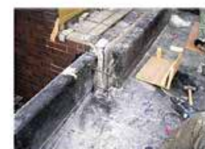
欠損部のモルタル補修
