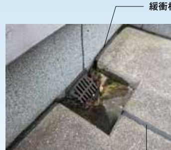
▲平場保護コンクリートと 立上り露出防水層間に 緩衝材設置
