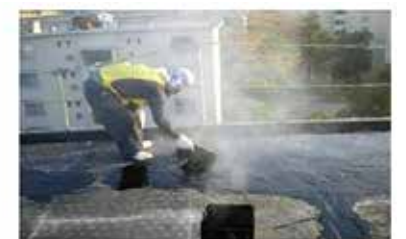
下地調整及び仮防水処理
